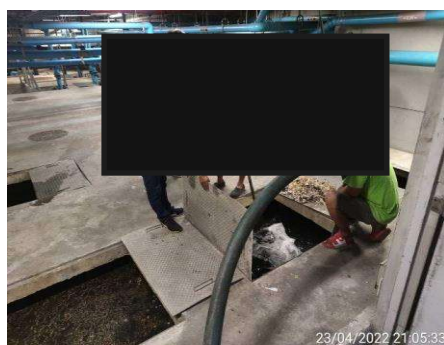
รูปที่ 2-24 การสูบน้ำจากตะกอนในถังเกรอะ
