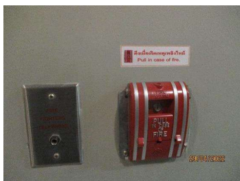
ระบบแจ้งสัญญาณเตือนเพลิงไหม้
