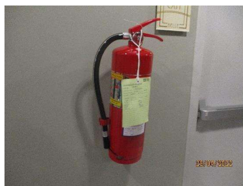
ถังดับเพลิงแบบผงเคมีแห้ง
