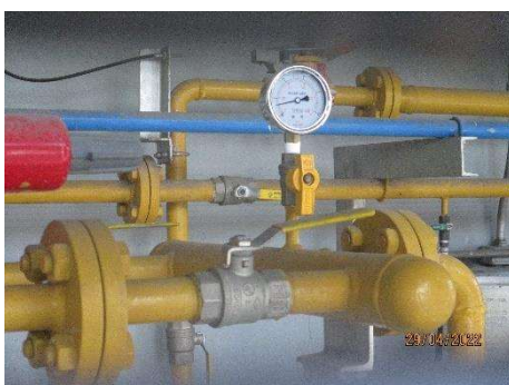
รูปที่ 2-44 อุปกรณ์ตรวจวัดก๊าซบริเวณถังเก็บก๊าซหุงต้ม ของพื้นที่ส่วนกลาง
