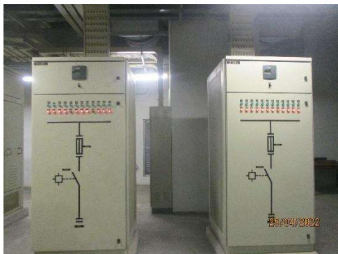
รูปที่ 2-36 อุปกรณ์ควบคุมค่าเพาเวอร์แฟกเตอร์
