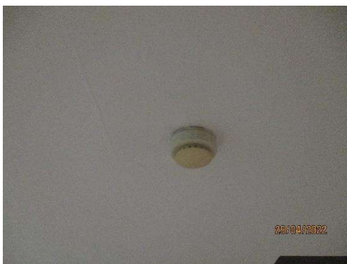
รูปที่ 2-38 อุปกรณ์ตรวจสอบจับความร้อน
